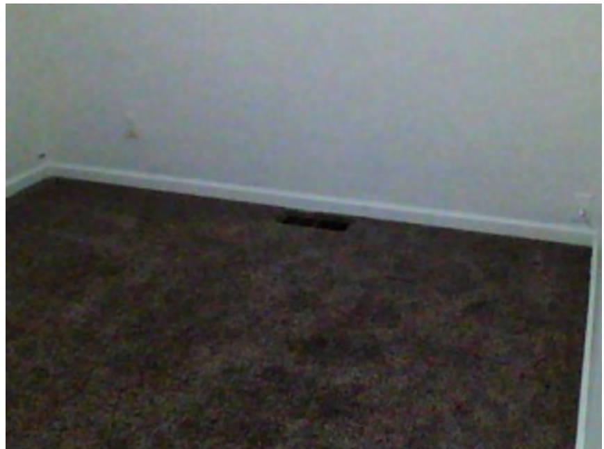
AC & DUCT CHECK.jpg
